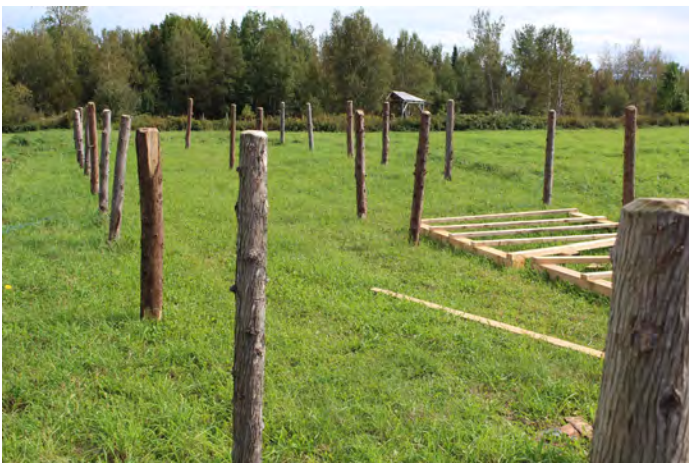
Lieu désigné pour la construction d'abris pour chevaux
