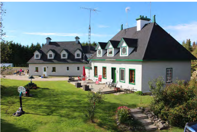
La résidence principale et le bâtiment rénové
