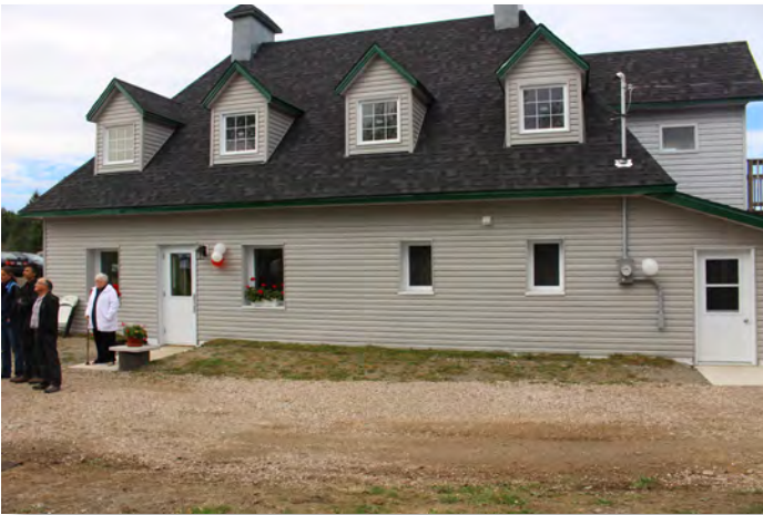
Le nouveau bâtiment complètement rénové
